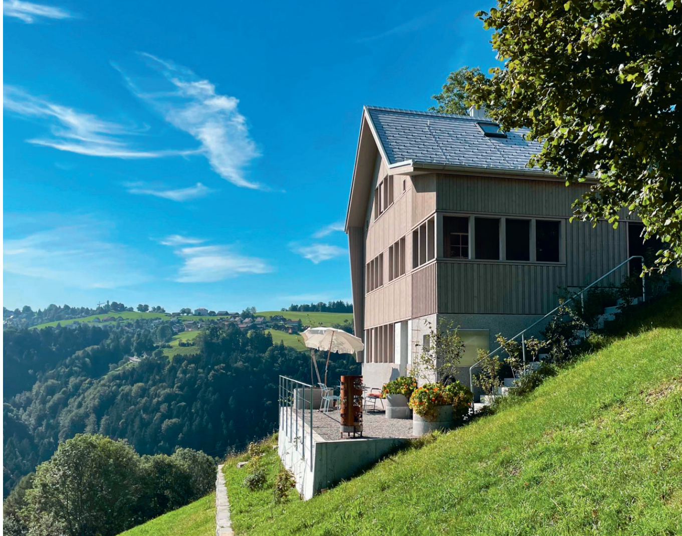
In Lobenschwendi, einem Weiler am Rand von Rehetobel (AR), ist als Ersatz für ein altes Weberhöckli ein Atelierhaus entstanden. In Form und Gestaltung lehnt es sich am Vorgängerbau an (Foto unten). Typisch fürs Appenzellerland sind die gereihten Fenster, die viel Licht ins Innere lassen.
