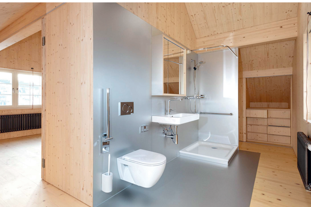
Die Nasszelle ist mit Aluminiumblech ausgekleidet und bildet einen starken Kontrast zum wohnlichen Holz.
