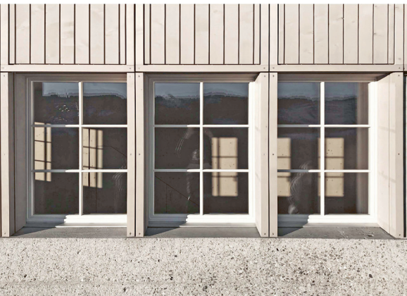
Statt traditioneller, glatter Füllungsplatten wurde eine stehende Sichtnut-Täferverkleidung eingesetzt.
